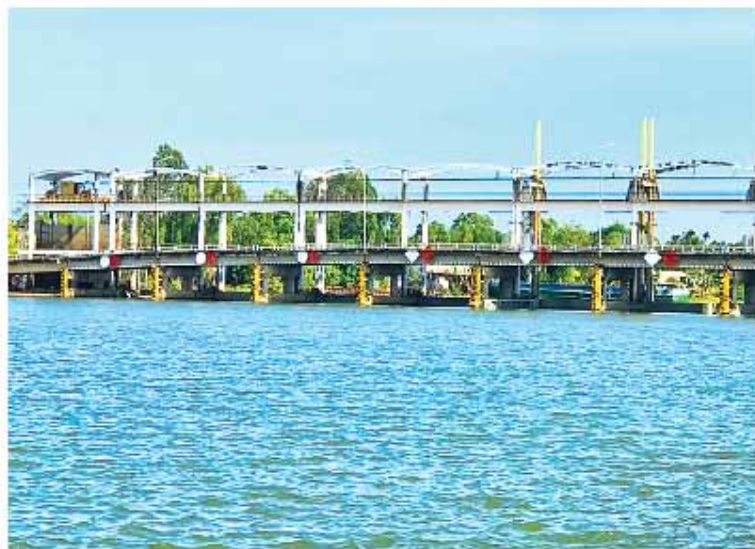
Cống Láng Thê trên địa bàn huyện Gò Công Long, chính thức vận hành vào ngày 14/11/2006. Ảnh: Sưu tầm
